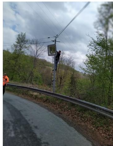
Afin de renforcer la sécurité des automobilistes, **un miroir permettant de visualiser les véhicules arrivant de face a été installé au niveau de la route qui traverse le hameau de Coursenon.**
